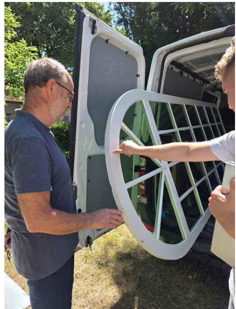
Die neuen Fenster werden angeliefert
