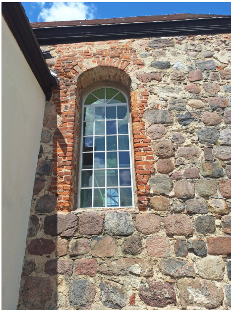
Die neuen Fenster sind eingebaut
